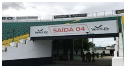
Figura 09 – Identificação de saída
