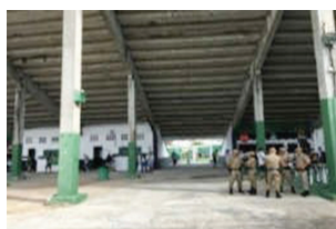
Figura 02 – Acesso ao estádio
